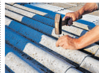
Asbestziegel
